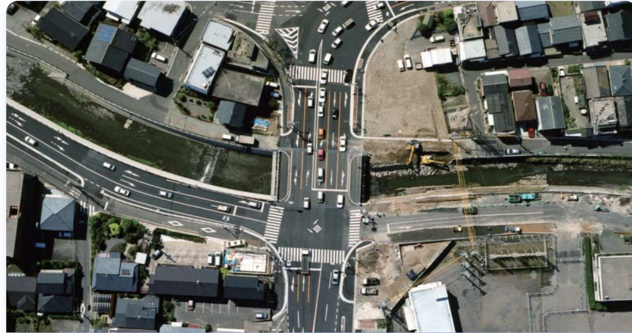
▲新川（河川改修工事） 12
