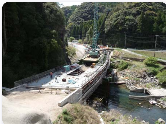
▲国道223号（妙見1号橋）①
