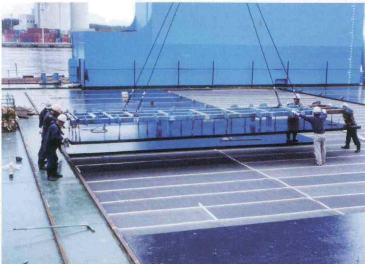
フローティングドック上のKAMの敷設状況
