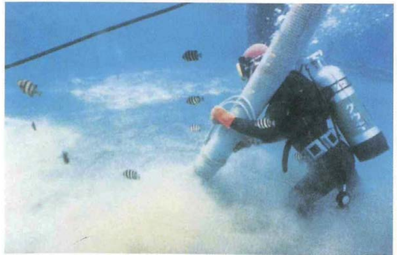
鯛が遊泳する中でハイドロクリート打設中
