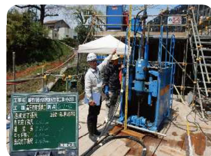
施工管理支援状況 (OJT)
