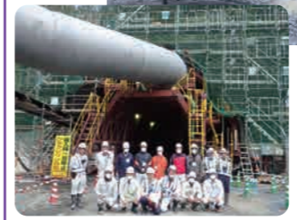
⑤ 名瀬瀬戸内線 (宮古崎トンネル) L = 2 3 1 6 m (H29 ~ 施工中)
