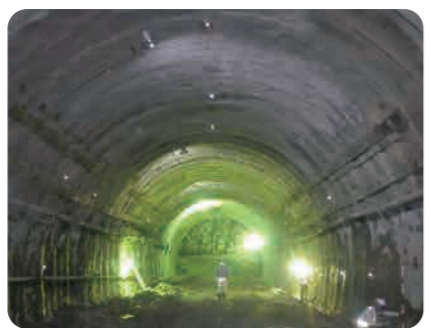
[トンネル] 奥之宇都線宇都トンネル (始良市) NATM・機械掘削工法
