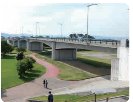
[橋梁] しらさぎ橋 (霧島市) PC 5 径間連続ラーメン箱桁橋
