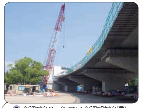
⑤ 新町線2（〔仮称〕新町跨線橋）
