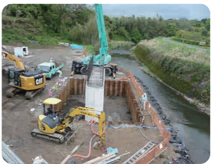
施工状況等の確認
