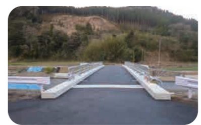
復旧状況（鹿屋市 荒平橋）
