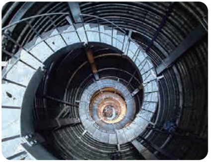
[集水井] 深港川 (大隅地域振興局) 集水井 (φ3500 H=46.0m)
