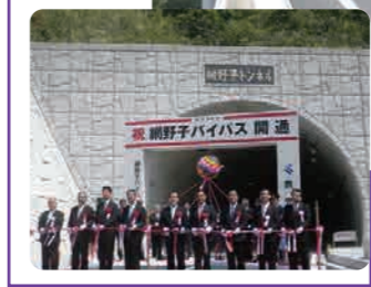
④ 国道 5 8 号 (網野子トンネル) L = 4 2 4 3 m (H22 ~ H25)
