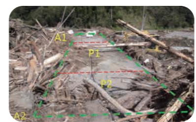
被災状況（鹿屋市 荒平橋）
