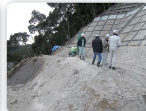
施工体系等の確認
