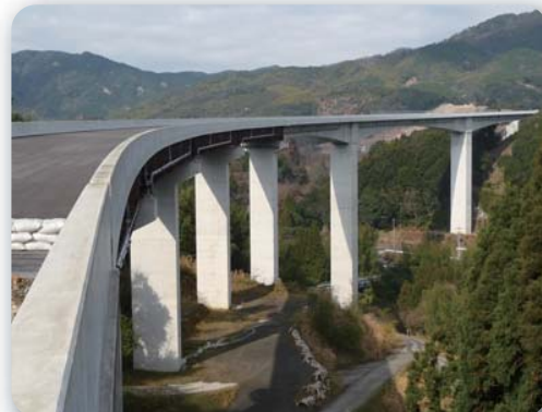
〔橋梁〕泊野3号橋 鋼4径間連続非合成鉄桁＋ PC3径間連続ラーメン箱桁曲線橋
