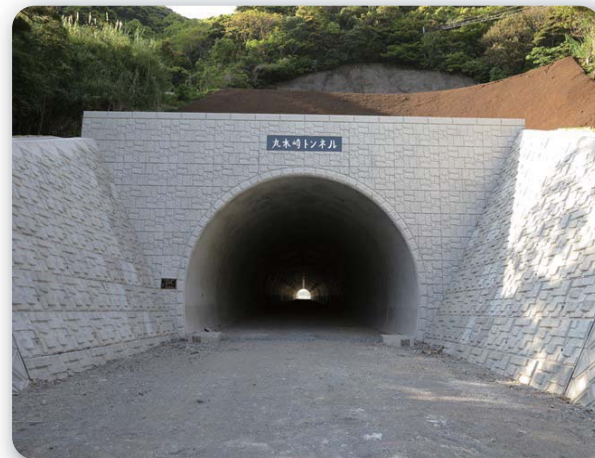
③ 国道226号（丸木崎トンネル）
