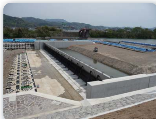
〔河川〕二級河川米之津川 六月田堰（SR合成起伏堰）
