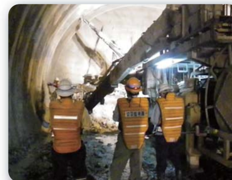
監視状況（切羽）
