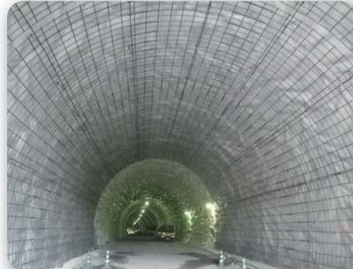
〔トンネル〕蘭牟田瀬戸3号トンネル NATM発破工法 L=1,674m
