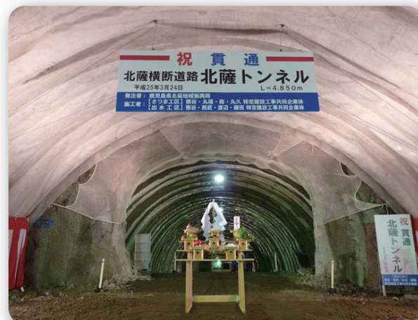
⑤ 北薩横断道路（北薩トンネル）
