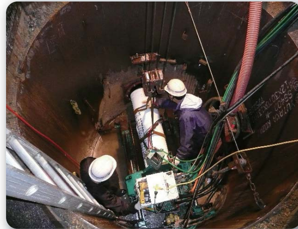
① 鹿児島東市来線（電線共同溝整備工事）
