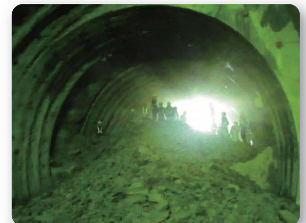
⑪ 国道58号（網野子トンネル）
