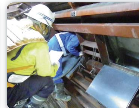
監視状況（覆工）
