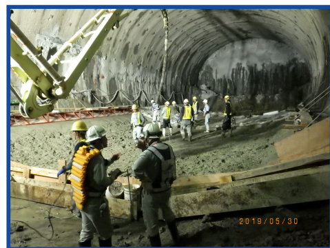
笠沙トンネル(現場見学)
