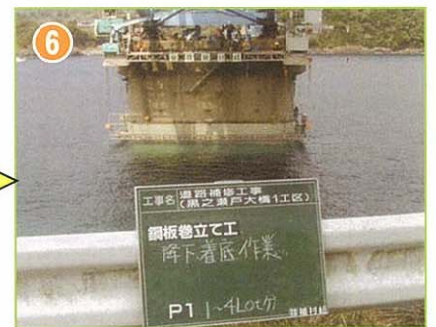
6 接合した分を海中へ落とし込み
