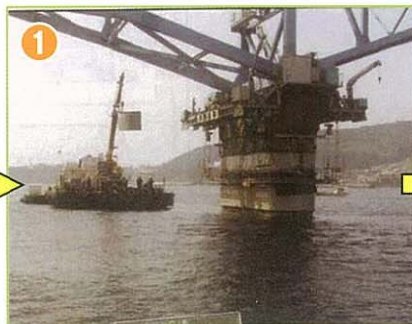
1 ピア上にクレーン仮設を設置し、鋼板を海上運搬
