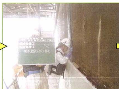
鋼板と橋台の隙間を無収縮モルタルで充填
