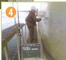
4 接合部分を塗装
