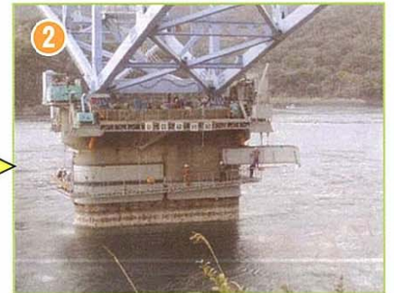
2 クレーンにて鋼版を吊り下げたまま組み立て
