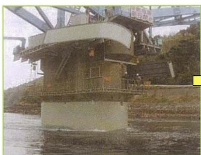
①～⑥の作業を、所定の高さまで繰り返す
