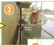
3 鋼版を溶接接合
