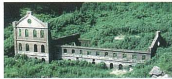
曾木発電所遺構
