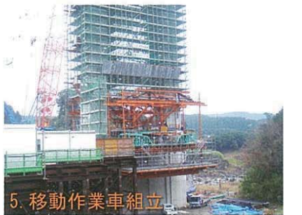
3,4 主塔・柱頭部の施工
