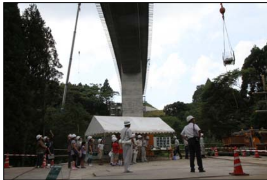
クレーンによる荷下ろし実演
